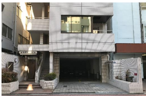
1樓為昏暗的停車場
