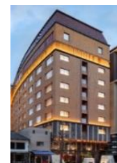
空庭TERRACE京都 空庭TERRACE京都別邸 2022年6月開幕，運營中
