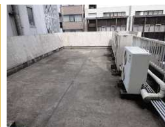
↑ 屋上グリーンテラス 新設工事
