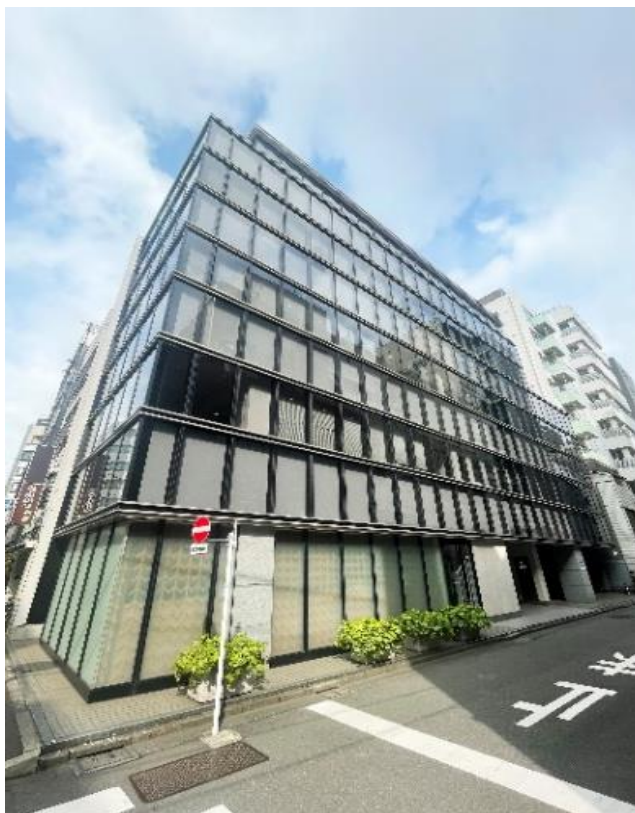
【建物外観(リブランニング後)】 東京都千代田区神田須田町 一棟収益ビル 鉄骨・鉄骨鉄筋コンクリート造陸屋根地下1階付8階建
