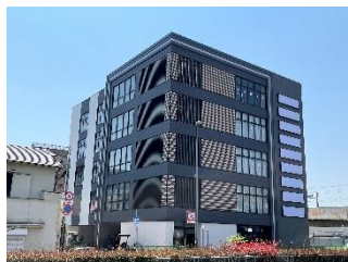
Compass M 兵庫西宮一棟 新築 クリニックモール 2025年9月売却
