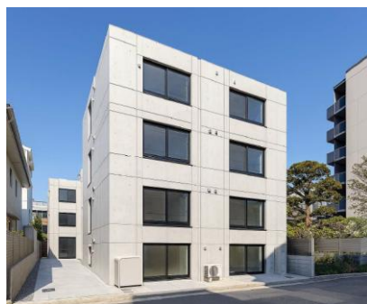
第1号案件:西落合防音マンション 7月売却 RC造壁式構造 4階建 1K:11戸、2DK:1戸、2LDK:1戸
