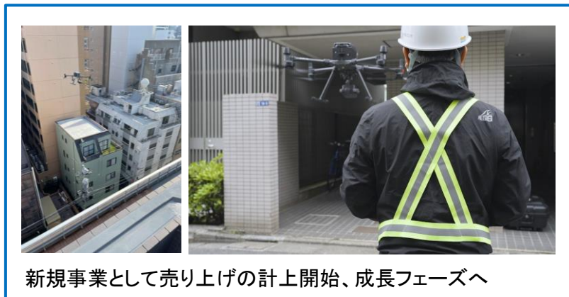
無人航空機(ドローン)による外壁調査を実施
