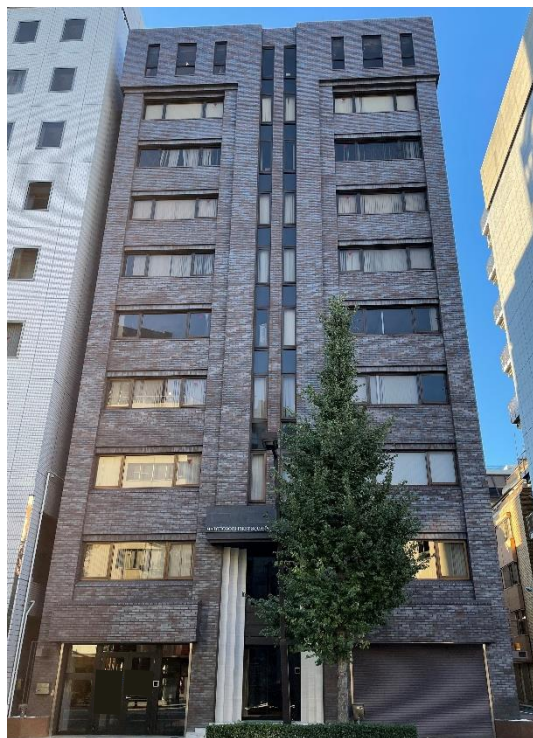
【建物外観(リプランニング後)】 東京都中央区八丁堀 一棟収益ビル 鉄骨鉄筋コンクリート造陸屋根 地下1階付10階建
