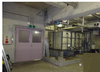
エレベーターも無く、未活用だった地下1F倉庫
