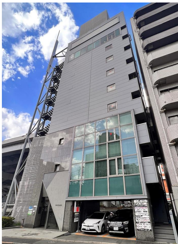
【建物外観 (リプランニング後)】 東京都千代田区飯田橋 一棟収益ビル 鉄骨造陸屋根 9階建
